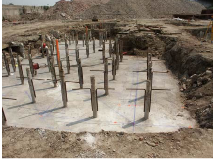
Micropali per il getto di piattabande di fondazione
