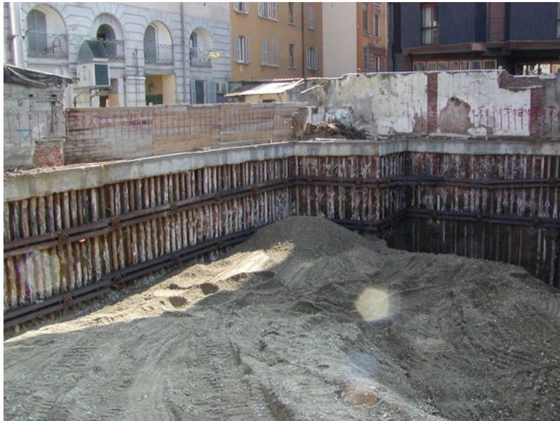
Realizzazione di micropali e tiranti per il sostegno degli scavi a confine con edifici.
